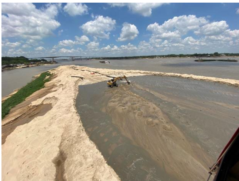
Figura 3. Relleno de parte de la isla San Francisco con arena extraída mediante el refulado ejecutado en el 2019.
