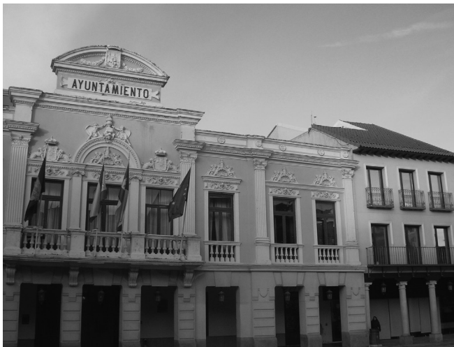
Figura 15. Fachada principal del Ayuntamiento de Guadalajara. La flecha señala el lugar de preinstalación de la estación fija de referencia GPS.
