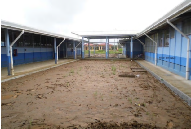
Figura 2. Nivel máximo alcanzado por la inundación en el emplazamiento de la nueva escuela de Upala.
