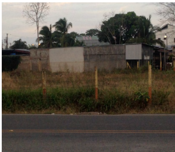
Figura 1: Marcas dejadas por la inundación del 24-25 de noviembre de 2016.
