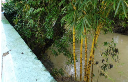
Figura 4. Dique construido en el sector sureste de la ciudad contiguo al río Zapote.
