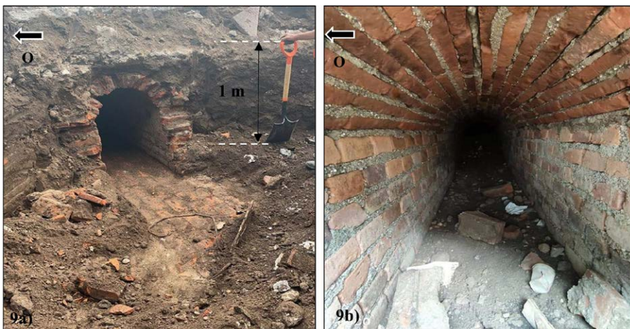
Figura 9. Estructura subterránea bajo la “Plaza Mayor” de la ciudad de Cartago, (Figura 9a) y su detalle interno (Figura 9b)
