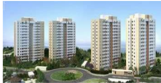
Condomínio Colina de Piatã (em construção)
