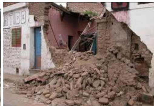
Imagen N°3: Casa de adobe destruida por el sismo de 7 de Septiembre de 2004. Catamarca.
