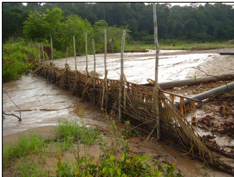
Figura 10. Barragem para contenção dos rejeitos.
